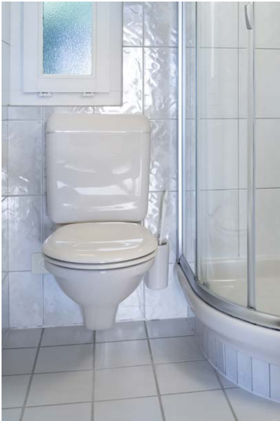
↑ AVANT WC conventionnel avec chasse d'eau apparente.
