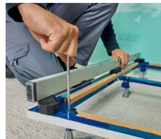
↑ Le réglage de hauteur des pieds s'effectue confortablement par le dessus à l'aide d'une clé Inbus. Cela permet de garantir la pose à fleur de sol du receveur de douche Geberit CleanFloor30.
