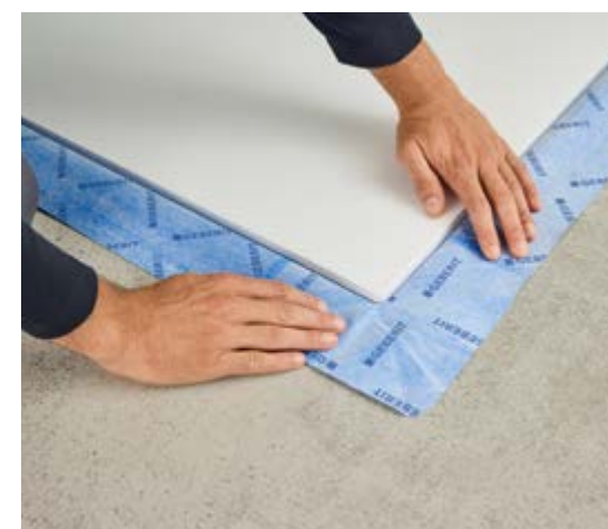
↑ L'étanchéité montée en usine du receveur de douche Geberit CleanFloor30 est sûre à 100 % et facilite le travail sur le chantier.
