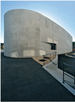
LE LAUFEN FORUM EST L’AFFIRMATION DE L’ARCHITECTURE DE LA MARQUE SUR 6 500 MÈTRES CUBES, UN CENTRE DE VISITEURS ET D’EXPOSITION CRÉÉ PAR LE BUREAU D’ARCHITECTURE DE BÂLE NISSEN & WENTZLAFF.
