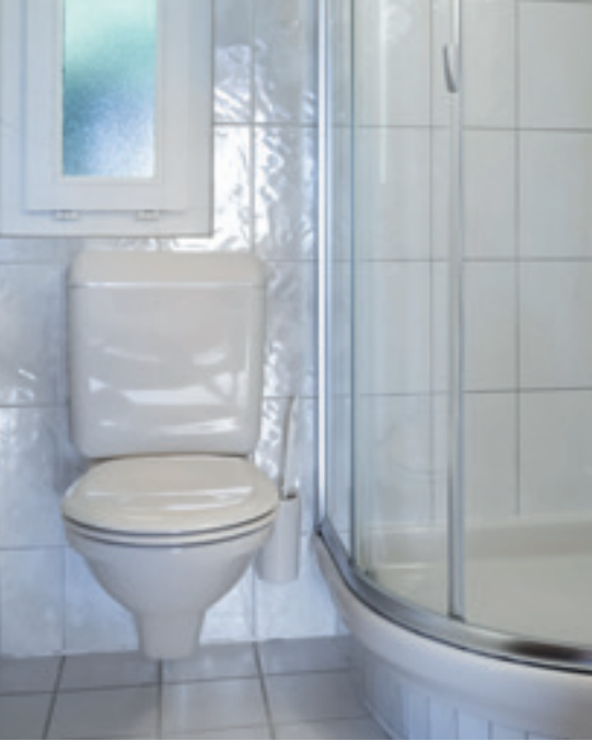
AVANT Situation de montage avec réservoir apparent
