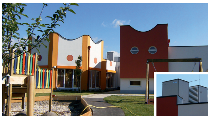
Plus grandes puissances de chauffe et efficacité accrue pour un jardin d'enfants: remplacement du système de chauffage par 2 pompes à chaleur aérothermiques Belaria® en cascade.
