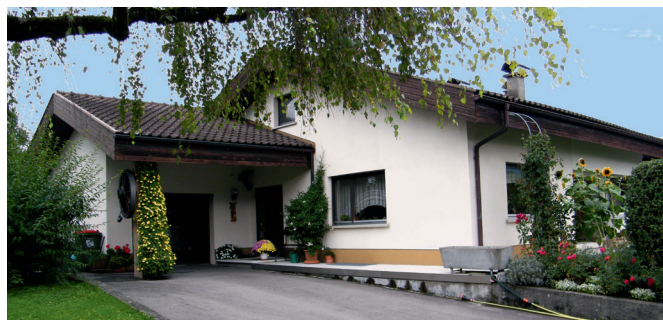
Rénovation du système de chauffage avec pompe Belaria® compact IR installée à l'intérieur.
