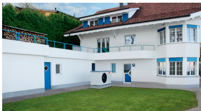
Rénovation du système de chauffage avec une pompe à chaleur Belaria® twin A (17) installée à l'extérieur.
