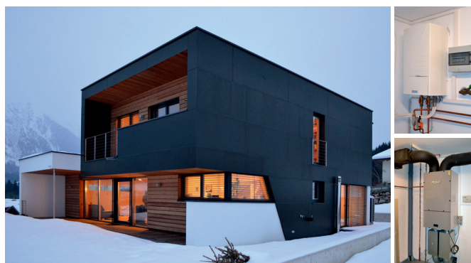
Température ambiante confortable dans une maison individuelle grâce à une solution système Hoval pour le chauffage, l'eau chaude sanitaire et l'aération douce.
